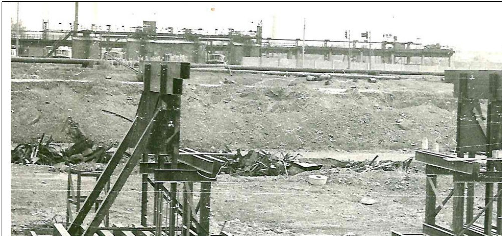
Рис. 1. Монтаж анкерно-упорного стенда для испытаний свай вдавливающей нагрузкой
