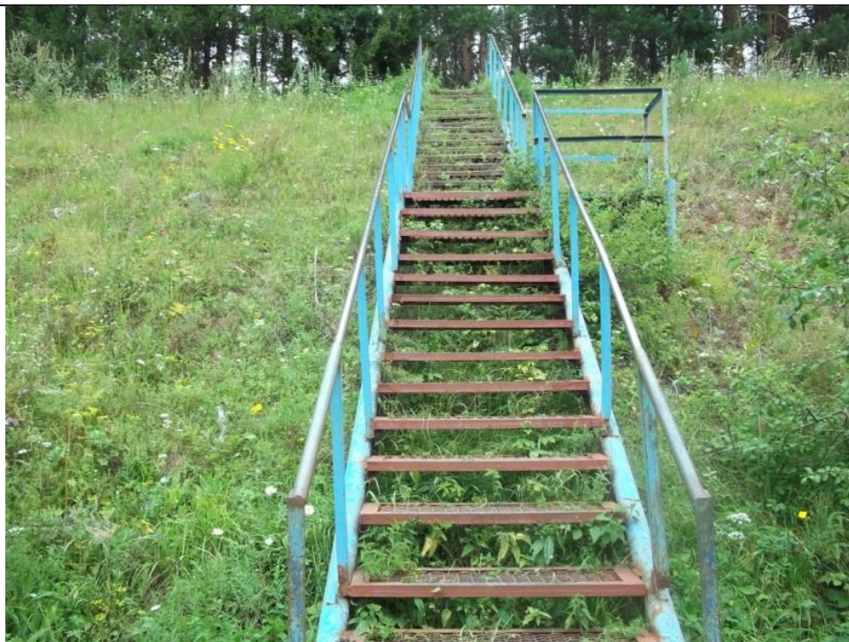
Рисунок 2 – Металлическая лестница в селе Завод Михайловский
